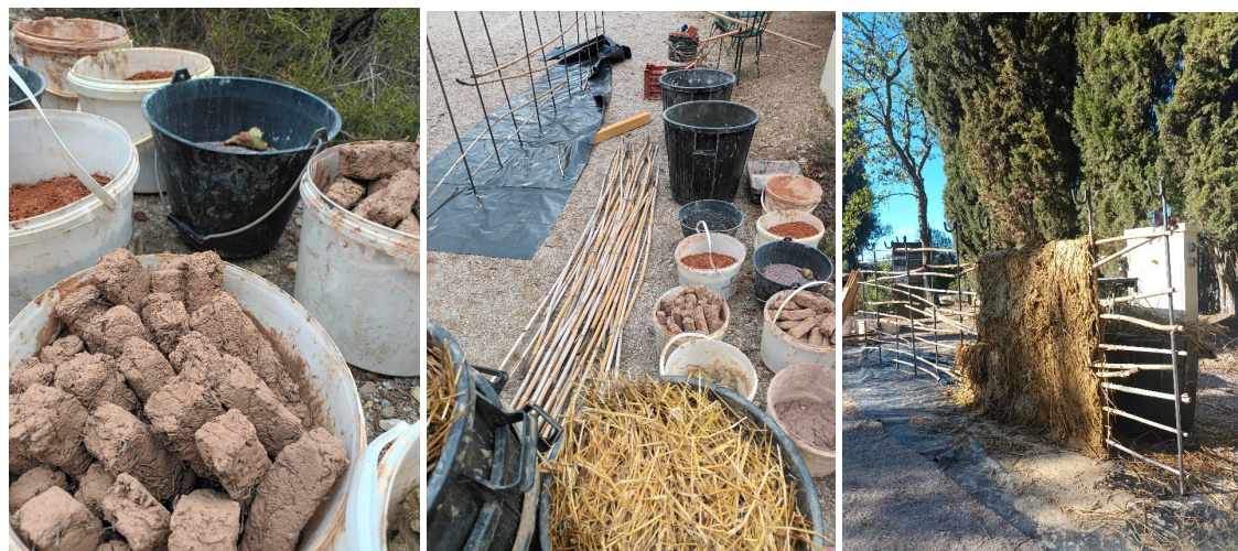
Matériaux et exemple de pose de terre crue sur clayonnage par l'association Terren l'ère .
